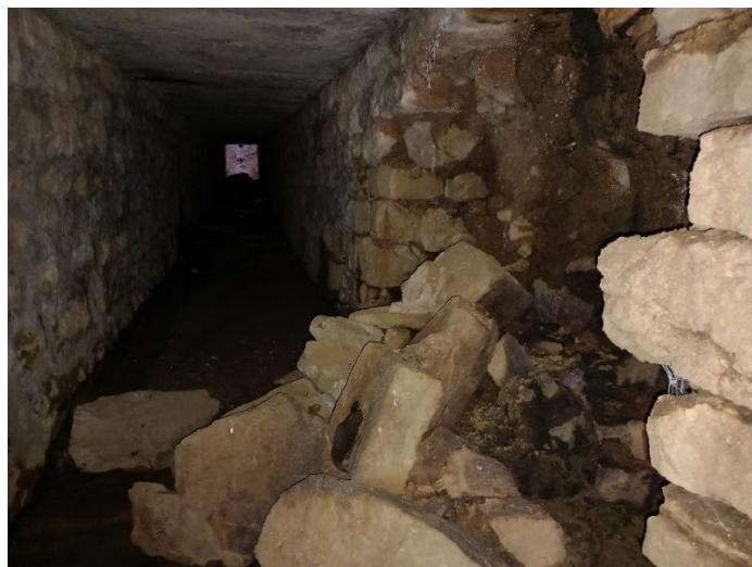
Figure 4 : Effondrement du piédroit de l'aqueduc sous la digue
