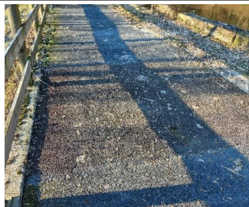
Figure 10 : Zone en enrobés reprise
