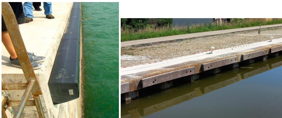
Figure 42 : Exemple de lisses de guidages en PEHD (ADC Maritime à gauche) – Bief 22 à droite
