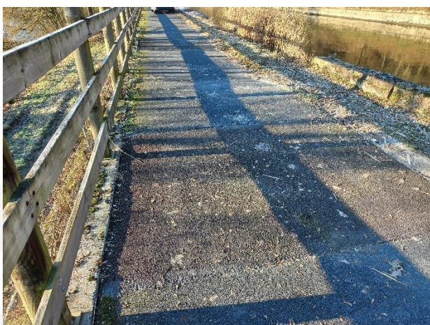
Figure 3 : Reprise de l'enrobé en crête
