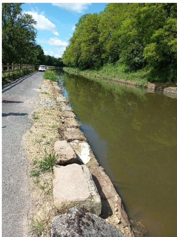
Figure 15 : Zone confortée avec membrane
