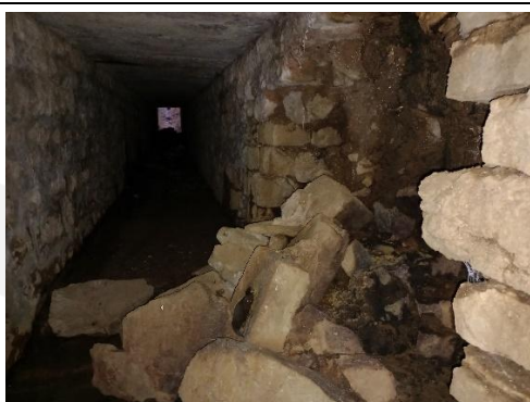
Figure 13 : Effondrement dans l'aqueduc
