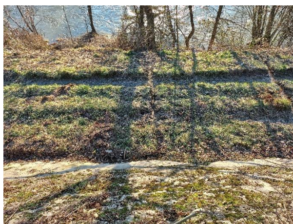
Figure 2 : Traces de fuites sur la risberme aval
