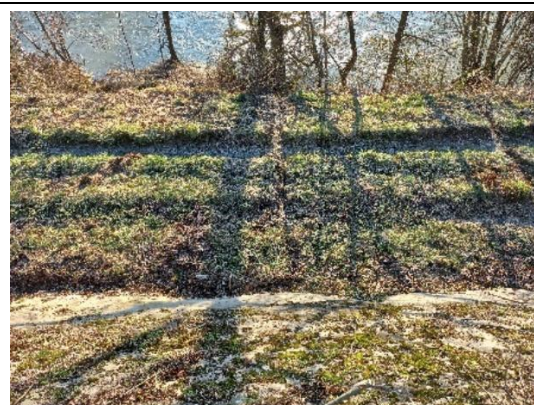
Figure 12 : Résurgences de fuites sur le parement aval
