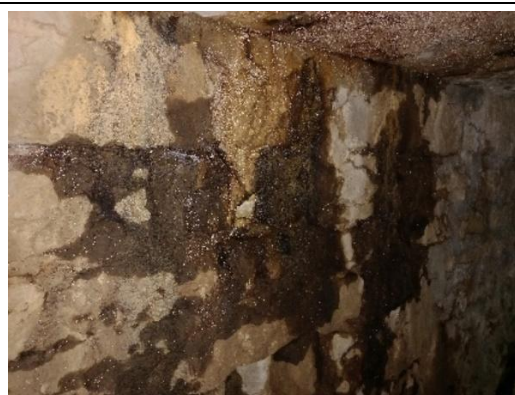
Figure 14 : Fuites à travers la maçonnerie de l'aqueduc
